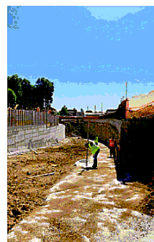
Il cantiere del sottopasso
